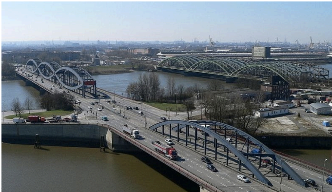
Neue Elbbrücke in Hamburg
